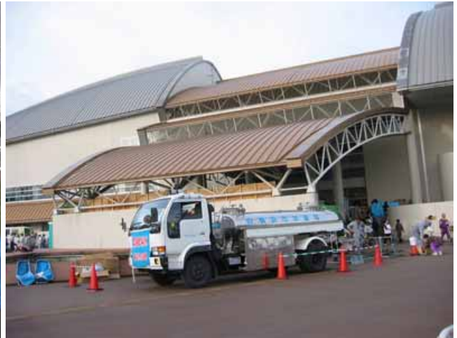
写真58： 小千谷市総合体育館 構造的な被害は見られなかった。中は支援物資と避難してきた人であふれていた。
