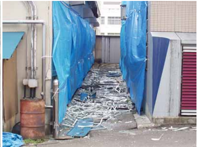
写真48： ガス爆発によるガラスの飛散
