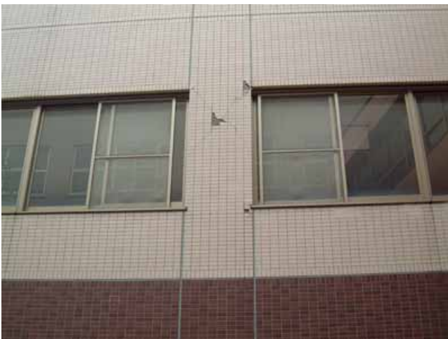
写真39: RC造5階建て(地域共同テクノセンター) 2階柱のせん断ひび割れ。1階および3階にも同 様のひび割れがあった。
