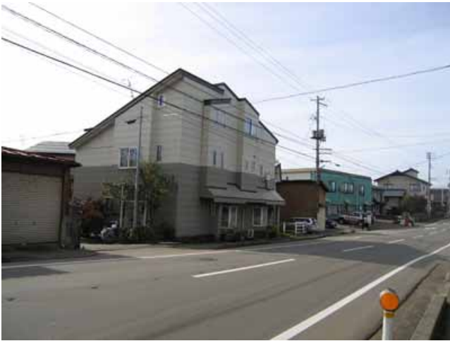
写真11: 木造3階建て住宅の棟瓦の落下 枠組壁構法であり、外観はほとんど無被害.
