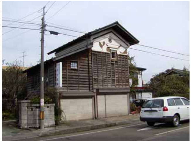
写真16: 土蔵の仕上げ(漆喰)の剥落 1階の間口に壁がなく、さらに高い建物であるにもかかわらず、被害は比較的軽微。
