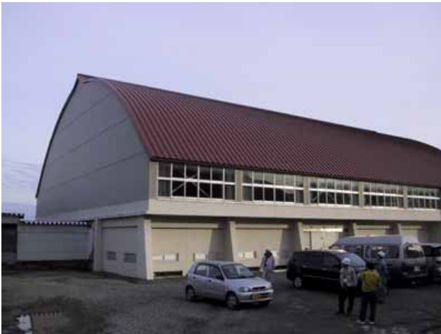
写真65: 1階RC造2階S造の体育館
