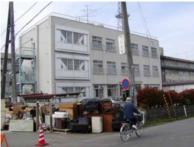
写真21: 耐震補強したRC造集合住宅 無被害. 1階柱脚には曲げひび割れもない.
