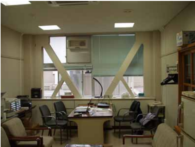
写真37: RC造4階建て校舎(4号館) Kブレースにより耐震補強済み。補強箇所 はかなり多いと感じた。
