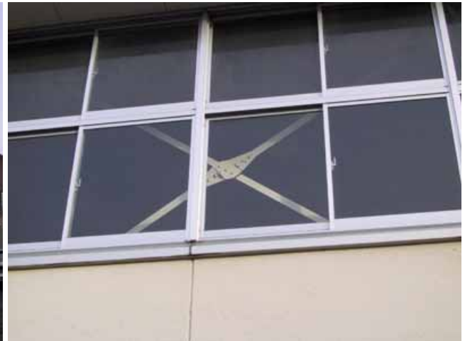
写真66: 写真65の建物のブレースの被害 ブレースのガセットプレートの座屈およびリベットのすべりが見られる.
