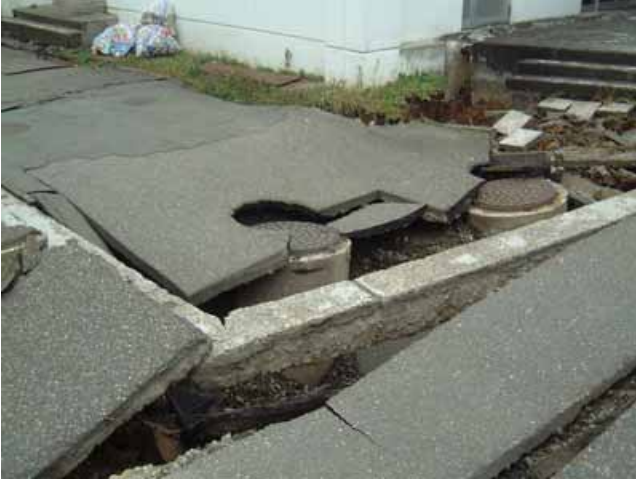
写真53：路面の崩壊
