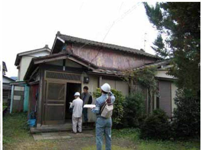
写真14: 木造平屋住宅 古い住宅であるが、外観・内部とも無被害。左写 真の建物同様、古くても無被害の建物もあった.
