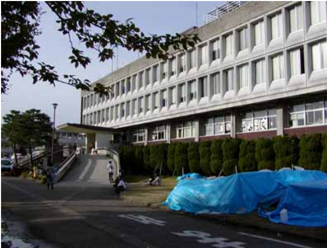
写真57： 小千谷市役所 わずかに損傷があるが、ほとんど無被害。
