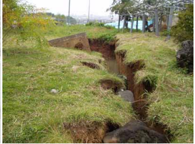
写真54：斜面崩壊にともなう地割れ 地盤は左側に移動。
