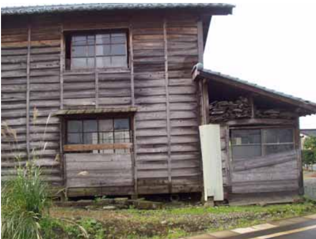
写真13: 木造2階建て住宅(空き家?) 非常に古く、基礎も束石であるが、外観は無被害.
