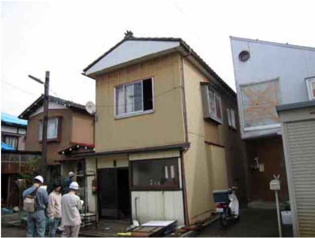
写真9: 狭小間口の2階建て住宅 残留変形により若干傾斜.
