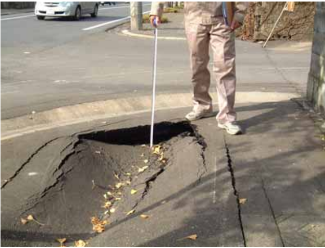
写真31: 道路の陥没
