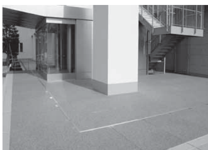
病院玄関付近
