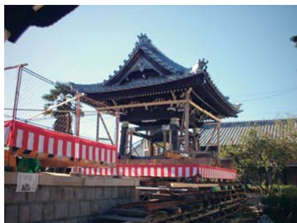
寺院の鐘楼 移設工事 地盤沈下による傾斜があり新設した杭基礎の石垣へ移築
