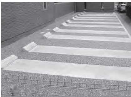
マンション駐車場
