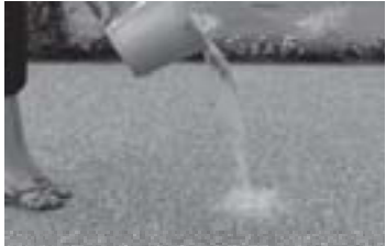
施工箇所の透水状況
