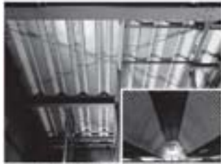
高層ビル等 吸音ダブルバック工法
