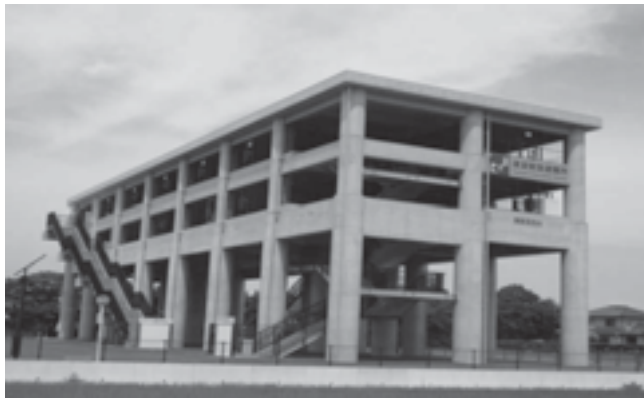
← 二見西津波避難施設 (基礎事業・コンクリート杭工事)
