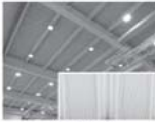
新築住宅 吸音ダブルバック工法
