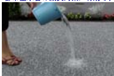
施工箇所の透水状況
