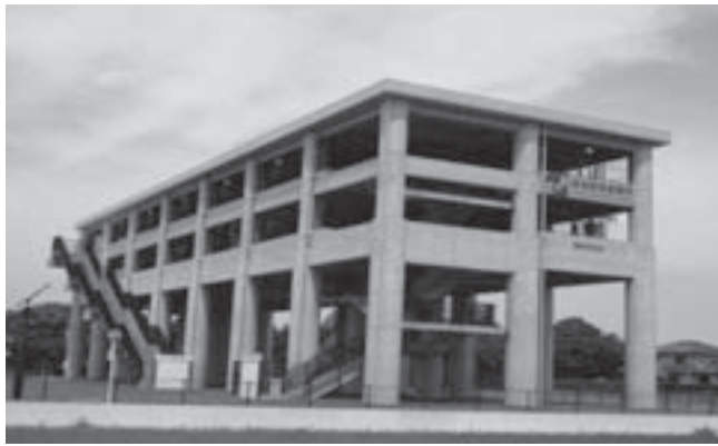
← 二見西津波避難施設 (基礎事業・コンクリート杭工事)
