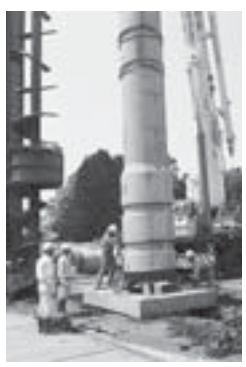
ハイビーエム(H・B・M)工法 <プレボーリング拡大根固め工法>
