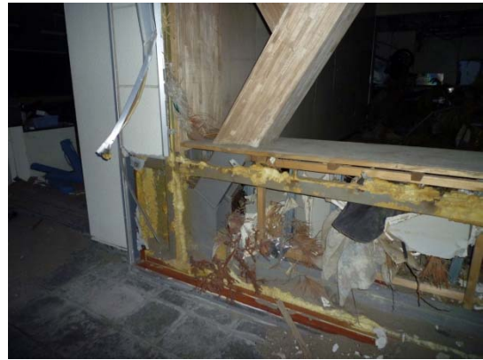
写真31：補強ブレース
