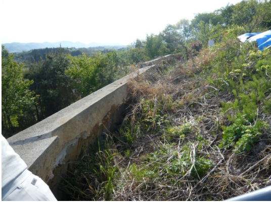
写真16：擁壁の崩壊
