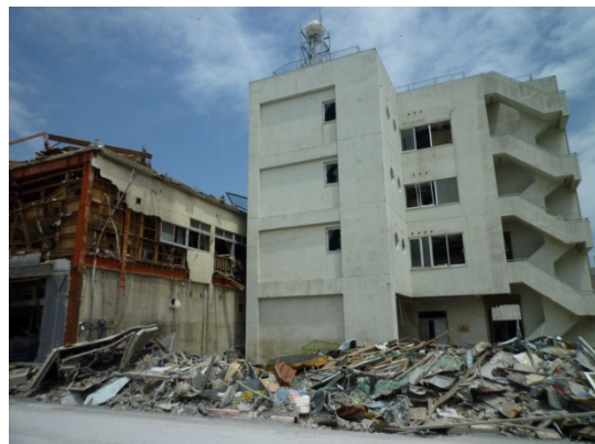
写真 45：躯体は健全な RC 造
