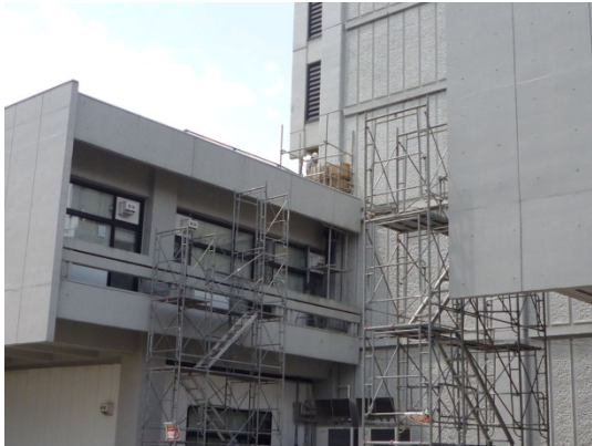
写真 1：柱脚の補強工事中
