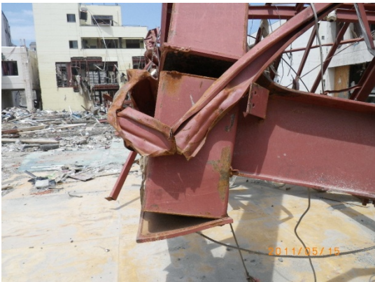
写真 42：隅肉溶接のダイヤフラム
