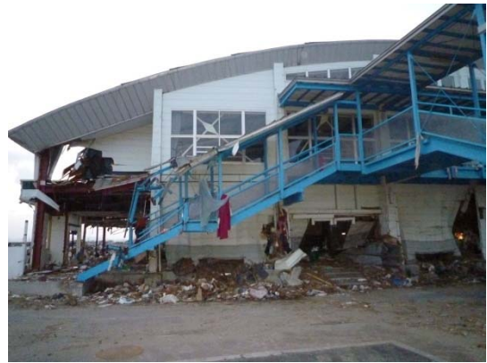
写真33：体育館の状況
