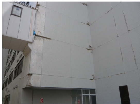
写真10：渡り廊下接続部
