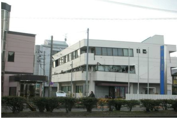
写真 20：2階層崩壊（宮城県事務協より提供）
