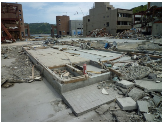
写真 44：基礎、土台のみ残る木造家屋
