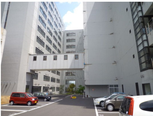
写真9：渡り廊下部の崩壊
