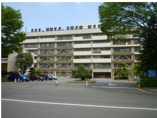
写真 3：外付け鉄骨ブレース補強済み
